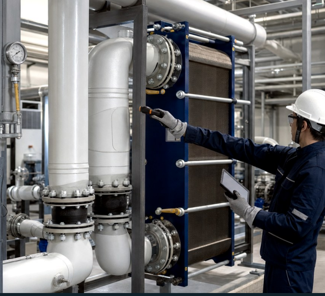
Mekanik ekipmanda saha ve uygunluk incelemesi
