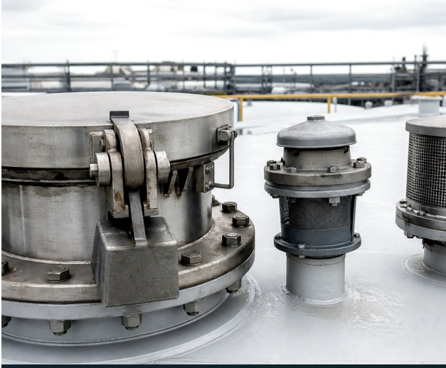
Tank çatısında markasız venting ekipman grubu
